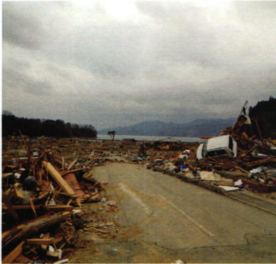
大槌町 壊滅状態の町並み
